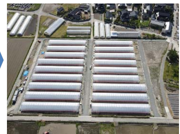
ビニールハウス設置
