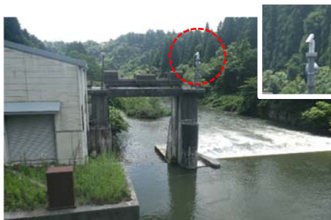
【西高峰頭首工の監視カメラ（飯豊町）】
