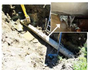
パイプラインの破壊による漏水
